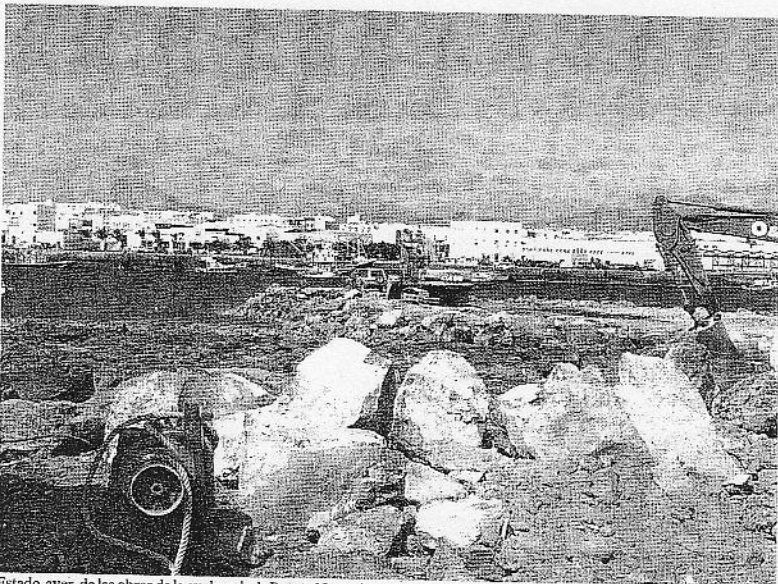
Estado, ayer, de las obras de la explanada de Puerto Naos. | D.H.
